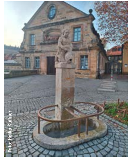
Sprudelt wieder: Der Trinkwasserbrunnen „Fischbrunnen“ wurde von den Bamberger Stadtwerken saniert, jetzt steht er am alten Platz am Kranen
